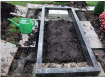
Montieren der Einfassung
