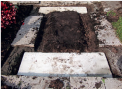
Ausgraben und Einbringen der Betonfundamente. Wichtig ist die exakte Berechnung, damit die Anlage nicht zu tief sitzt.
