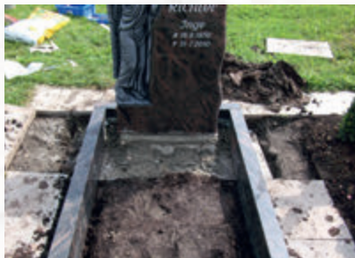
Verdübeln und Zementieren des Grabdenkmales
