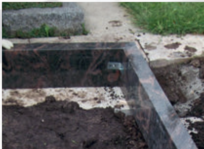
Verschrauben der Einfassung mit Winkeln
